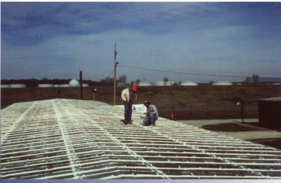
saumat ja ruuvit käsitelty Seam Guard sauma-aineella
